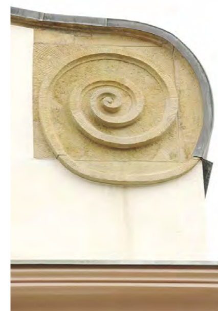
Die weisse Farbe der «Schnecken» wurde entfernt, der gelbe Sandstein kommt wieder voll zur Geltung.
